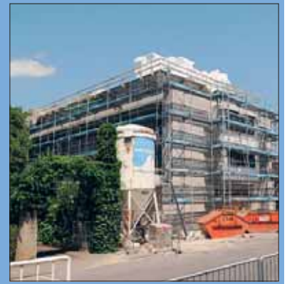
In zentraler und gleichzeitig ruhiger Lage an der Bahnhofstraße sind 21 Wohnungen entstanden.
